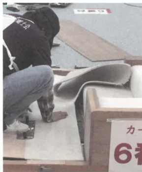
▲カーペット系床仕上げ作業 (全国技能グランプリ)
