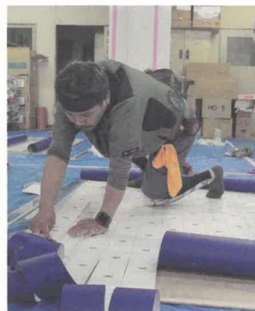
▲化粧フィルム工事作業
