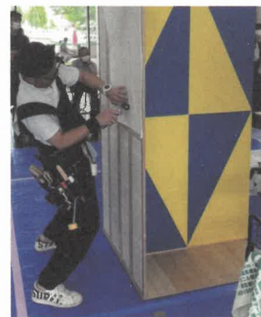
▲壁装作業 (京都グランプリ)
