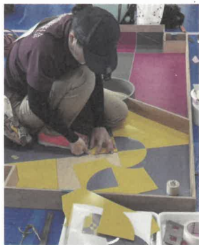
▲プラスチック系床仕上げ工事作業 (全国技能グランプリ)
